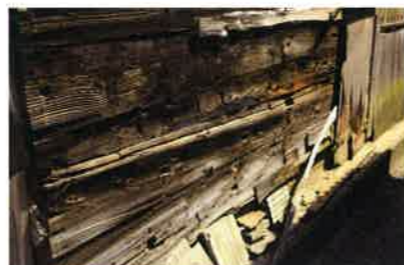
社屋の一部を補修するために使われていた木材は、四角い穴がところどころに開いている。聞けば和船の底板を再利用しているとのこと、イクスの穴だったらしい
